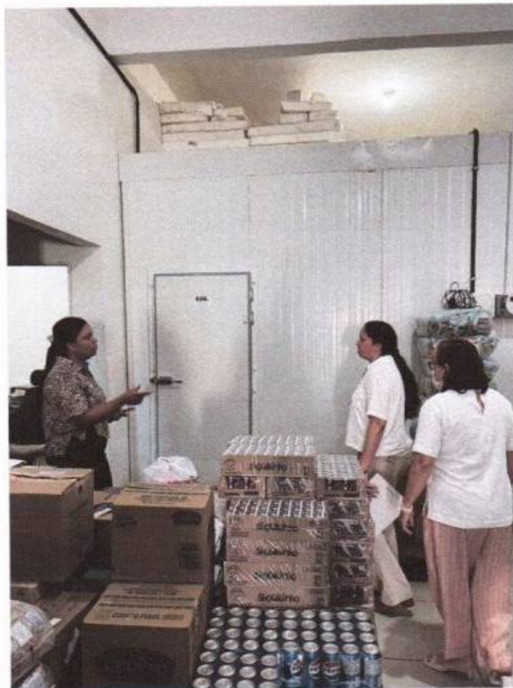
Imagens 06 e 07- Vistas externa da câmara fria.
