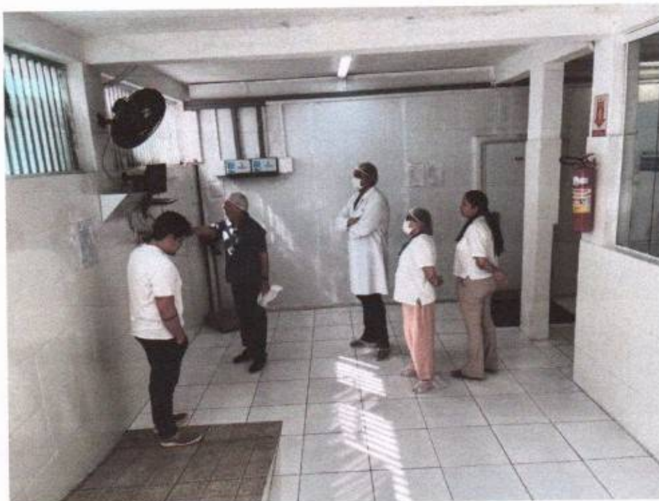
Images 06 e 07 - Vistas das câmaras frigoríficas
